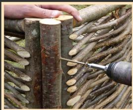
Tenez deux panneaux debout et à angle droit. Chaque panneau dispose d'un montant pré percé avec deux trous. Insérez la vis fournie dans le trou et vissez. Répétez l'opération pour chaque côté.
